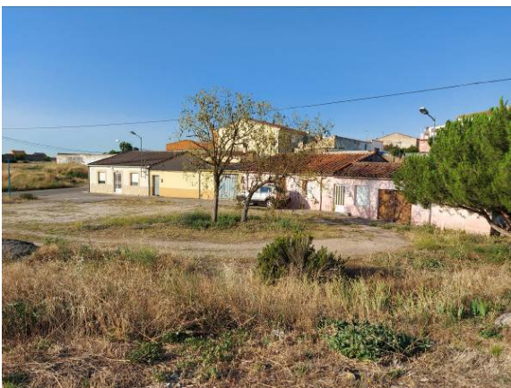
Foto 11: Construcción y accesos.
