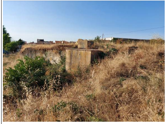
Foto 8: Restos de construcción en el sector.
