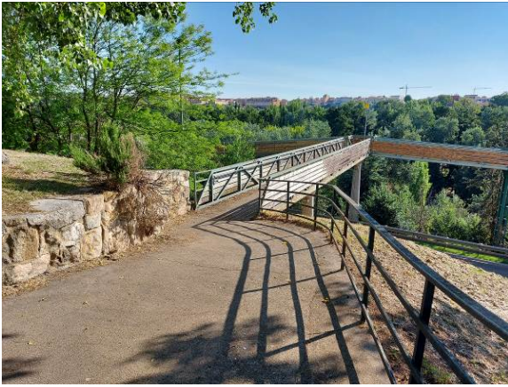
Foto 7: Paso peatonal elevado sobre la Nacional-122.
